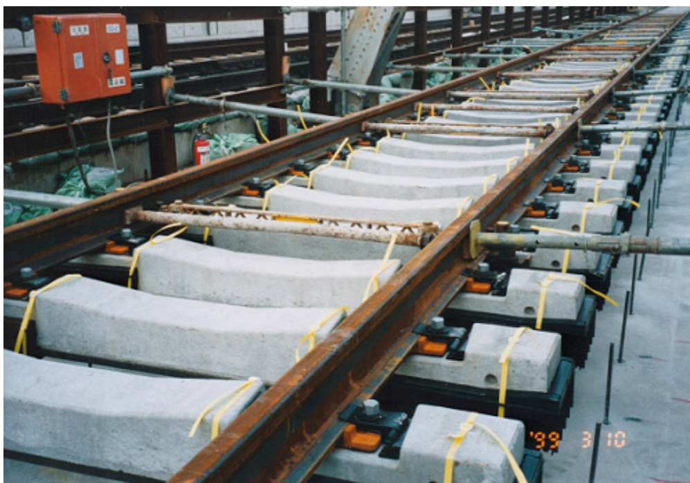
防振装置取付工事（防振ケース左右固定用PPバンドは型枠取付後にセットします。）
