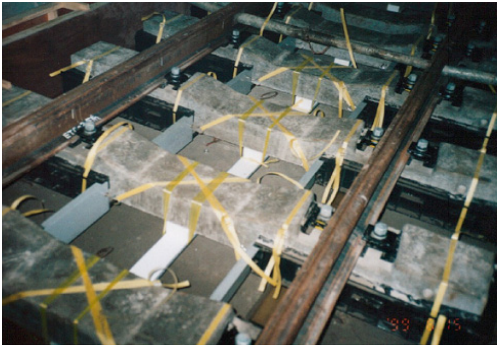
内型枠取付例
