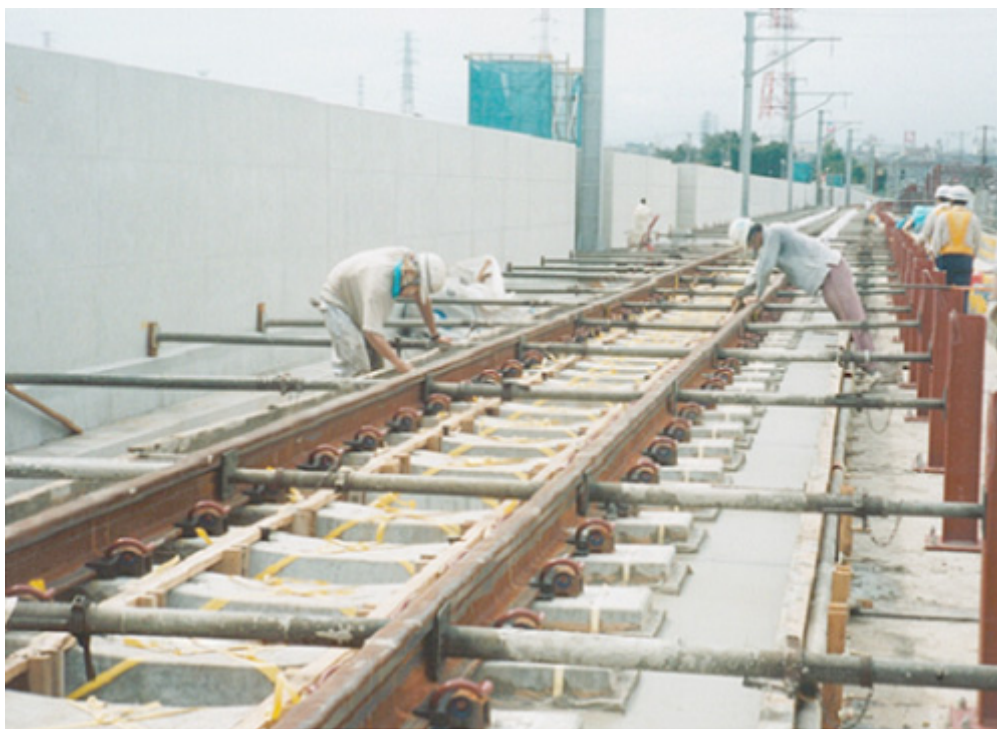
コンクリート打設工事（写真の現場は、前写真の現場と異なります。）
