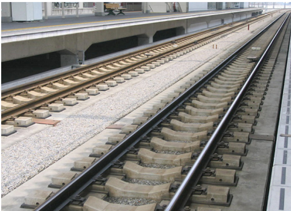
コンクリート打設工事終了後碎石散布例
